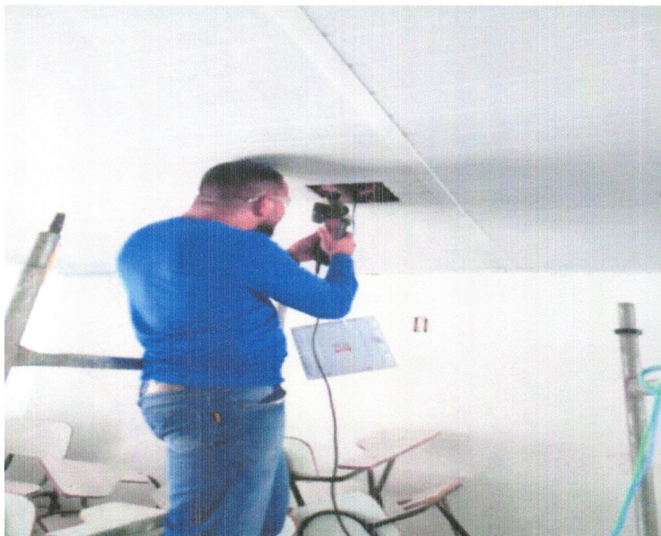
FOTO 12 – INSTALAÇÃO DE LUMINÁRIAS LED
