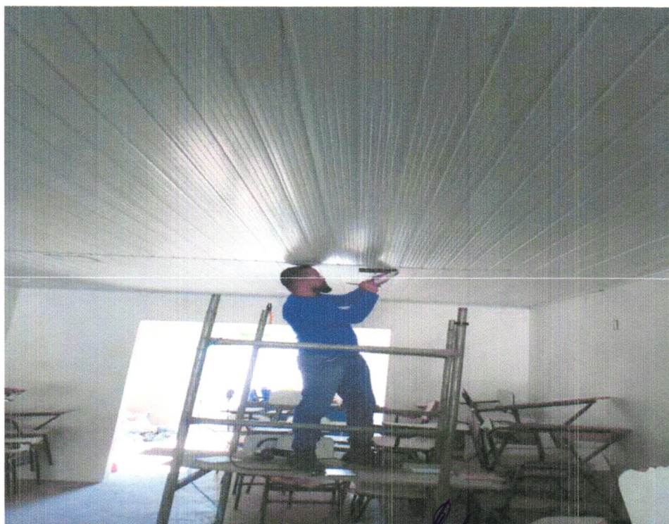
FOTO 12 – INSTALAÇÃO DE LUMINÁRIAS LED
