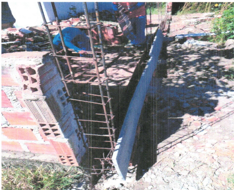
FOTO 16 – EXECUÇÃO DE ALVENARIA DO MURO
