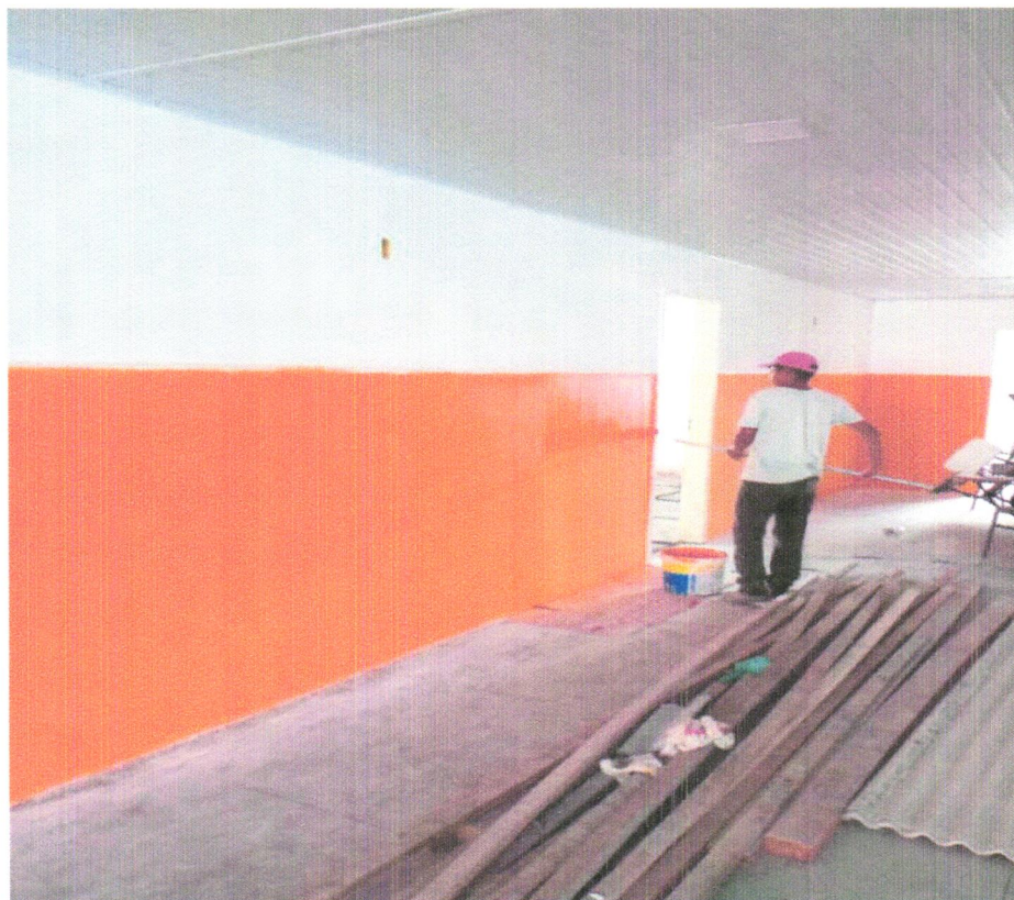
FOTO 18 – EXECUÇÃO DE PINTURA INTERNA
