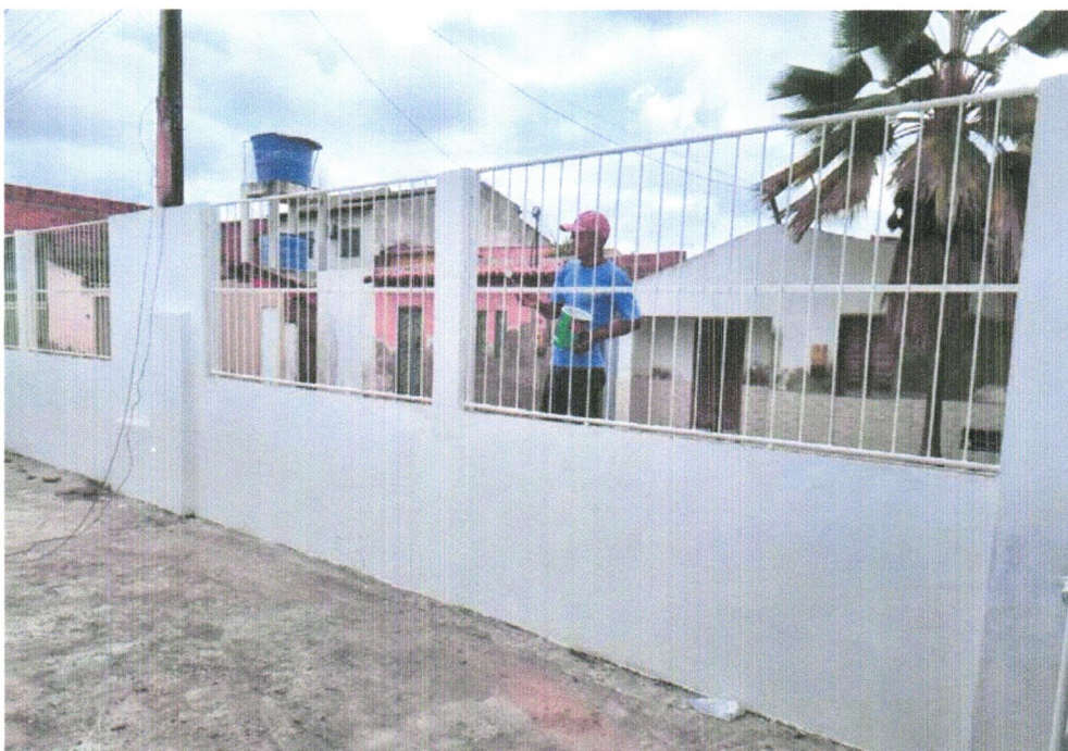
FOTO 20 – EXECUÇÃO DE PINTURA EM ESTRUTURA METÁLICA
