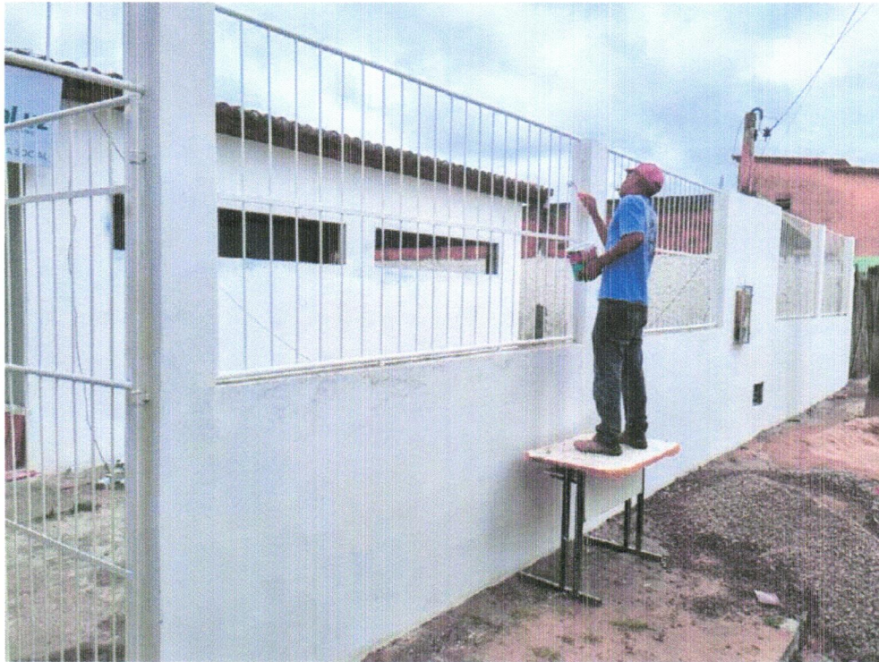
FOTO 20 – EXECUÇÃO DE PINTURA EM ESTRUTURA METÁLICA
