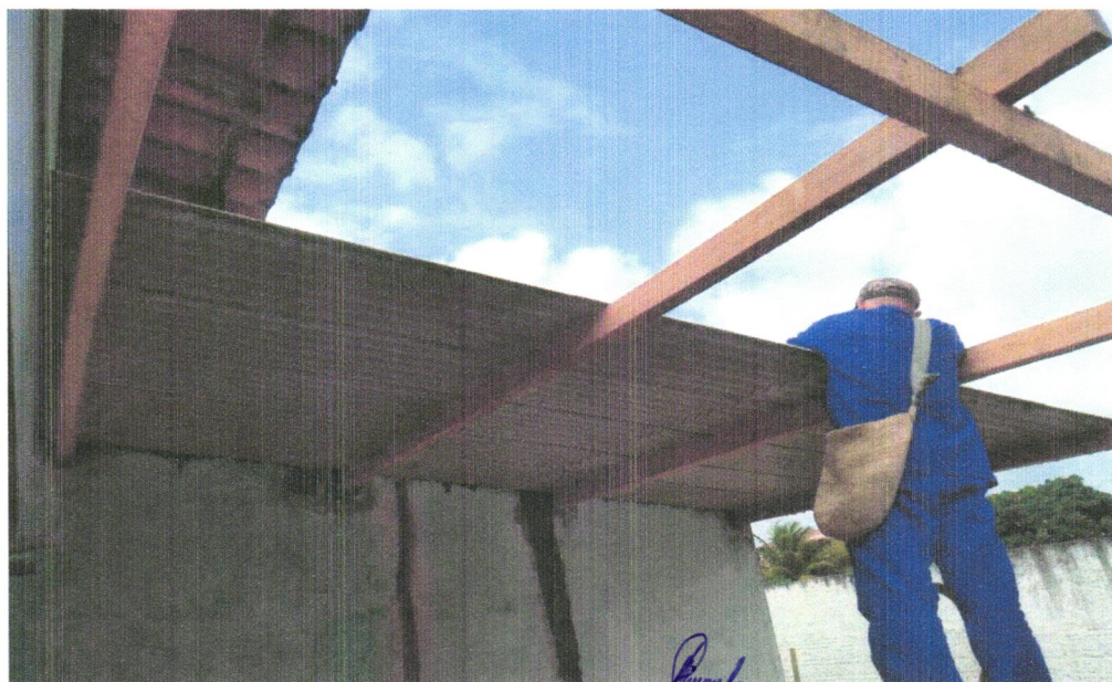
FOTO 08 - EXECUÇÃO DE COBERTURA DE FIBROCIMENTO
